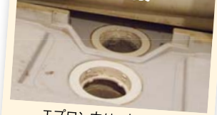
エプロン内は、水アカや石鹸カスで汚れています。
