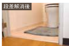
トイレの段差がなくなりました。
