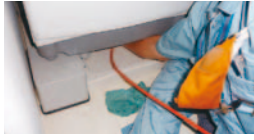
洗濯機を移動せずに配管の清掃が可能。
