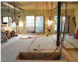
壁や天井を取り払い、スケルトン状態となった工事の様子（玄関より撮影）。手前の凹みは以前キッチンの床下収納だったスペース。このまま残り、現在はウォークインクローゼットの床下収納に。
