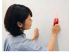
チェッカーで設置できる位置(下地のある位置)を確認する。 ※事前に配管の位置を確認
