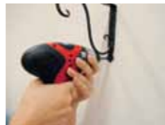
①で決めた位置にビスで棚受を固定する。(先にビスより細い穴を開けておくとラク)
