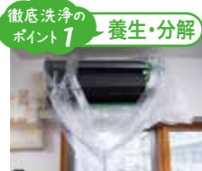
徹底洗浄のポイント1 養生・分解 お部屋を汚さないようしっかり養生し、プロが分解。
