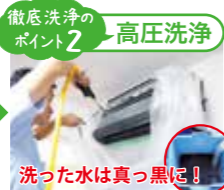
徹底洗浄のポイント2 高圧洗浄 洗った水は真っ黒に! ガンコなホコリやカビに洗剤を吹き付け、高圧の水で洗浄します。
